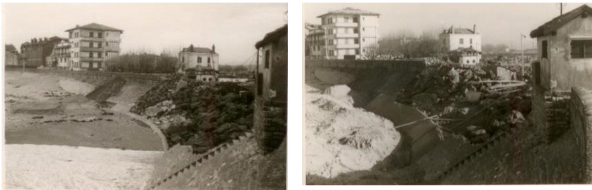
Figure 11 : Photographies des dégâts de la tempête de 1958
