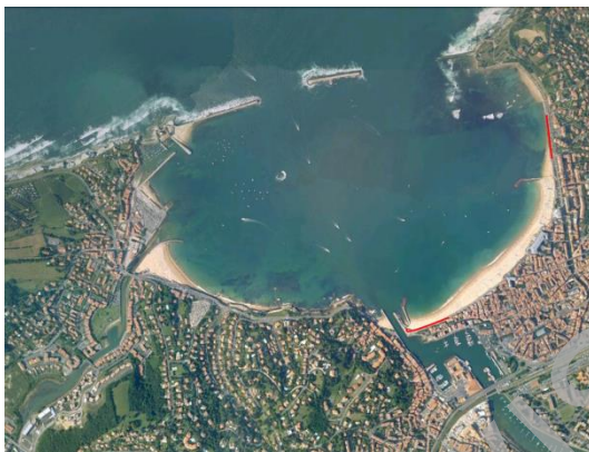
S1 : Présence des digues en mer et brèches dans le seuil de garantie
