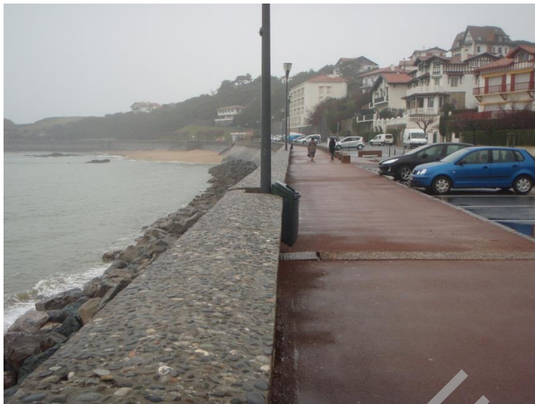
Figure 38 : Secteur d'application de la bande de sécurité liée à l'effet des vagues
