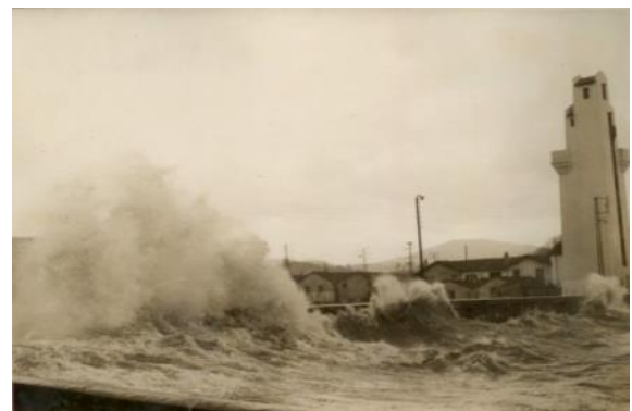
Figure 10 : Submersion du quai de l'Infante par voie de brèche (à gauche) et vague franchissant le perré côté Ciboure lors de la tempête de décembre 1951
