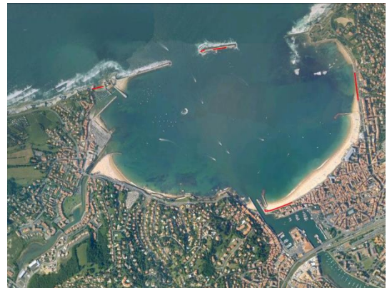
S4 : Brèches dans plusieurs digues en mer et brèches dans le Seuil de Garantie
