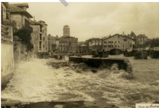
Figure 10 : Submersion du quai de l'Infante par voie de brèche (à gauche) et vague franchissant le perré côté Ciboure lors de la tempête de décembre 1951
